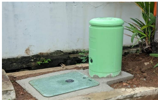
Gambar 2. 5 ODP Pedestal
