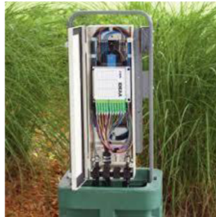
Gambar 2.2.5 ODP Pedestal
