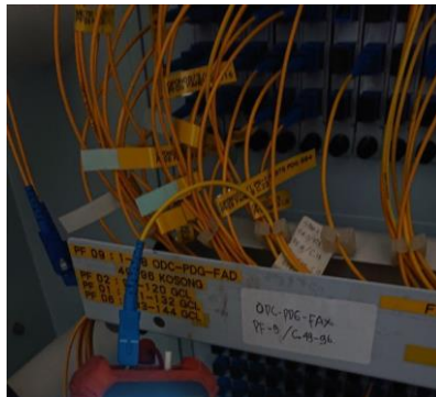
Gambar 2. 2 Perangkat ODC
