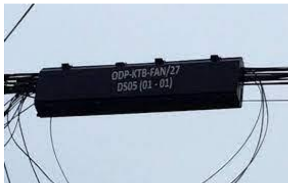
Gambar 2. 1 Perangkat ODP
