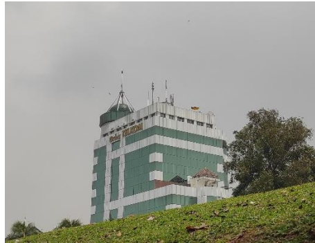
Gambar 1. 1 Merupakan Gedung PT Telkom Indonesia witel Tangerang
