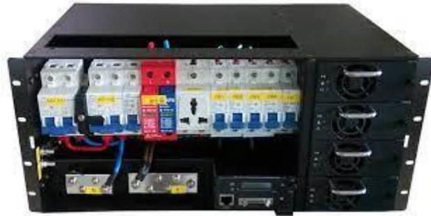
sistem ini bertugas untuk mengubah tegangan dari PLN 220/380 volt alternative current menjadi tegangan direct current untuk dikirim ke BTS.
