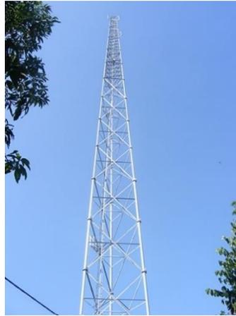
Menara segitiga ini terdiri dari tiga pondasi *tower*. Tiap pondasi disusun dalam beberapa potongan yang berkisar 4m - 5m. Untuk menghindari hal – hal yang tidak diinginkan, misal roboh sebaiknya *tower* ini memakai besi yang berdiameter diatas 2cm. Rata – rata *tower* jenis ini tingginya berkisar antara 40m dan maksimal 60m. Makin pendek tower tingkat keamanannya lebih tinggi. Kelebihan dari menara ini adalah komponennya lebih ringan sehingga menghemat biaya produksi dan pengangkutan.
