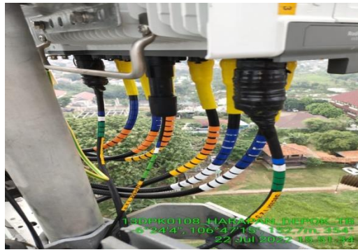
Gambar 3.13 Perekatan kabel
