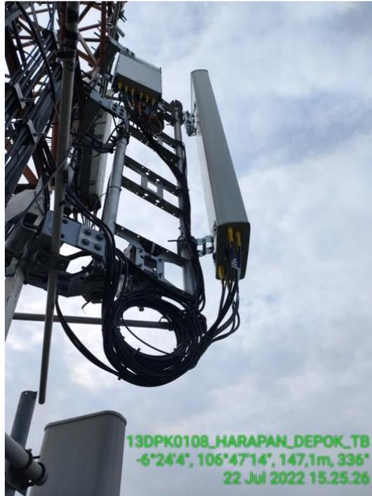
Gambar 2.1 Antena *sectoral* pada BTS
