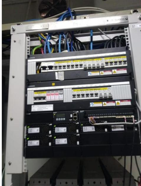
Gambar 2. 15 *Rectifier* Pada BTS [14].
