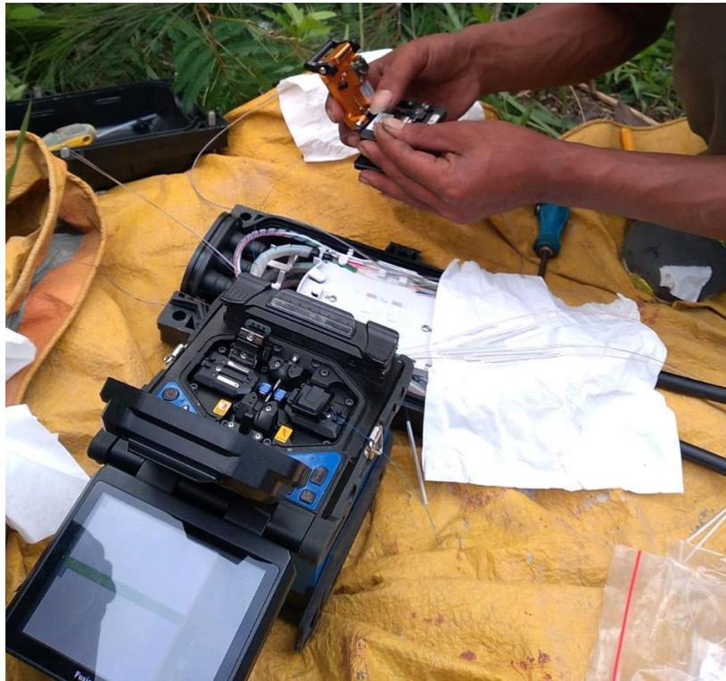
Gambar 2.4 alat yang digunakan pada penyambungan kabel *fiber optic*
