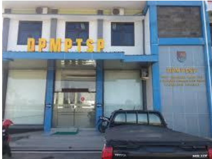
Gambar 1.3 Gedung Lokasi Kerja Praktik
