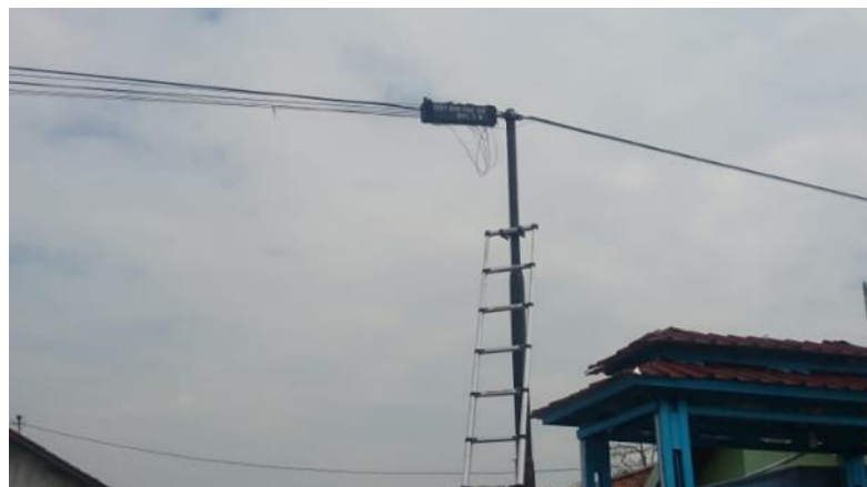
Gambar 2.4. Optical Distribution Point (ODP)
