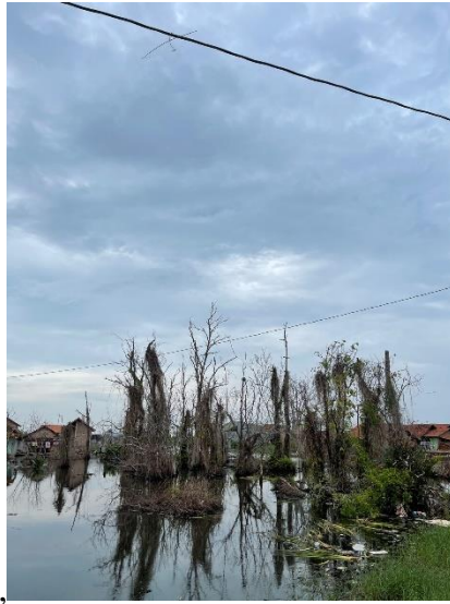
Gambar 3. 3 Banjir Rob di Kelurahan Bandengan, Kecamatan Pekalongan Utara, Kota Pekalongan
