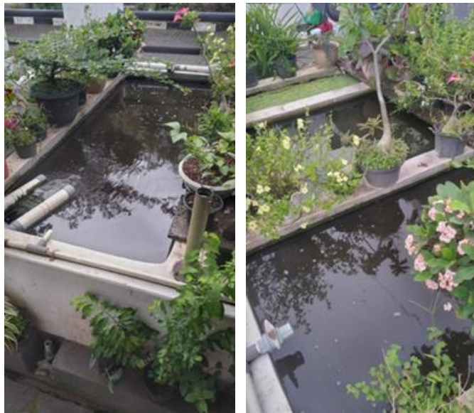
Gambar 3.2 Kolam cadangan air bersih (Sumber: dokumentasi penulis, 2021)
