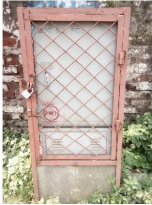
Gambar 2. 7 Perangkat ODC
