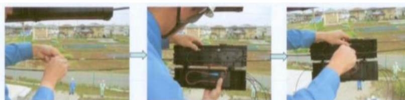
Gambar 2.5 Pemasangan ODP Pada Kabel Distribusi
