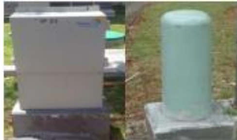
Gambar 2.13 ODP tipe pedestal [9]
