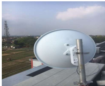
Gambar 3. 10 Kemiringan Antena Pemancar
