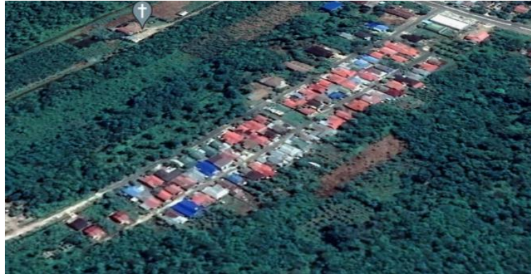
Gambar 3.3 Perumahan Kahayan Permai di lihat dari samping menggunakan Google Earth .
