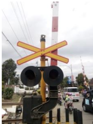
Gambar 1 Kelengkapan Pada Pintu Perlintasan JPL 360
