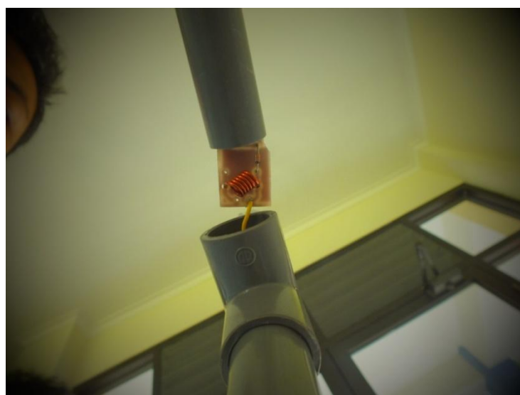
Gambar 3.6 Penyambungan antara antena dan kabel RJ58
